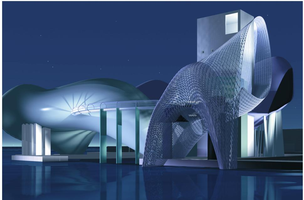
La seconda parte dell'edificio del foyer, s'ispira alle grandi costruzioni dell'ingegneria tradizionale come autostrade, fabbriche etc., rielaborando in una grande scala i concetti elementari del sistema costruttivo del c.a. Essenzialmente composta dalla giustapposizione slittata di una struttura a ponte e di una torre alta a base rettangolare, la prima concretizza il piano di pavimento del foyer a quota venti metri ed è ulteriormente complessificata
