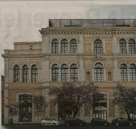
Studi Corrodi il palazzo che ospitò, fra gli altri, l'atelier di Trilussa, oggi sede del
